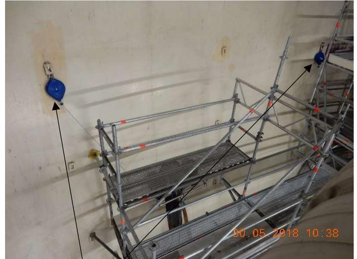
**Balancer zur Sicherung des Crawlers**
