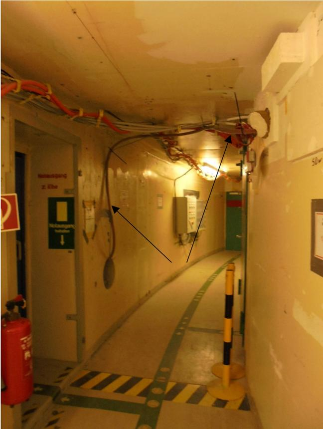
**Führung HD-Schlauch + Steuerkabel**
